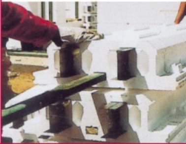
Die Unterseite der Deckenfläche kann verputzt oder verspachtelt werden. Einfachste Montage von Verkleidungen und Holzdecken durch bauseitiges Einschleiben von Dachlatten.
